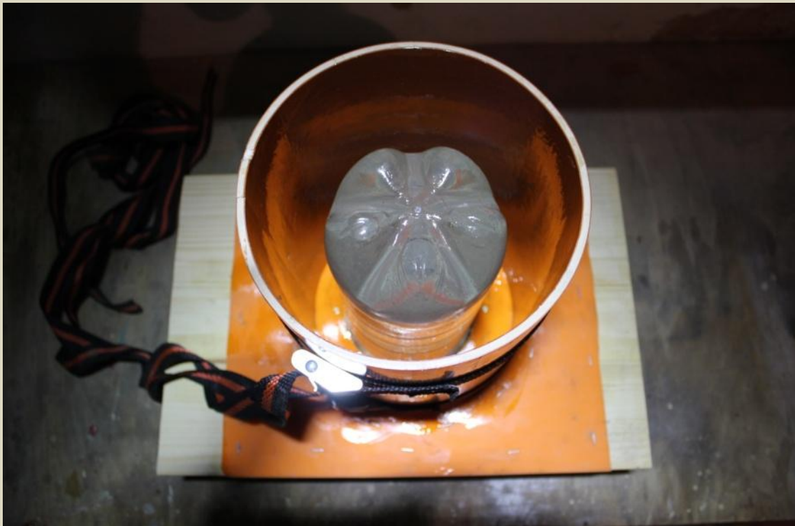
Den Zwischenraum mit dem Holzbeton befüllen
